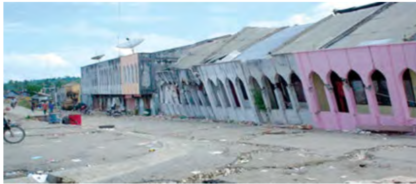
Gambar 3 Akibat Gempa Bumi
