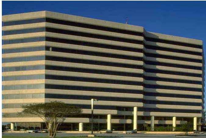
Gambar: 1-5 Gedung yang akan direnovasi
